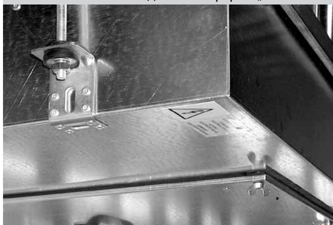
Рис. 5 – монтаж на подвесках в форме „Z“
