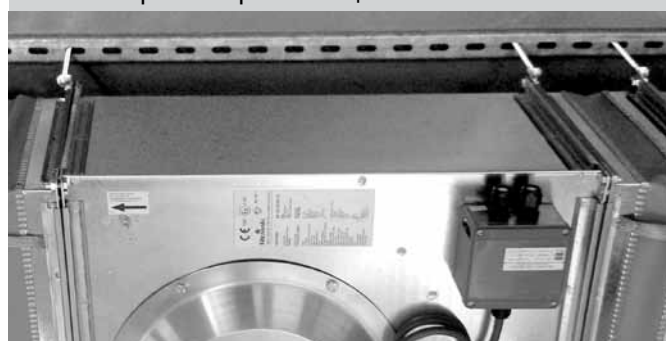
Рис. 9 - крепеж при помощи пластин
